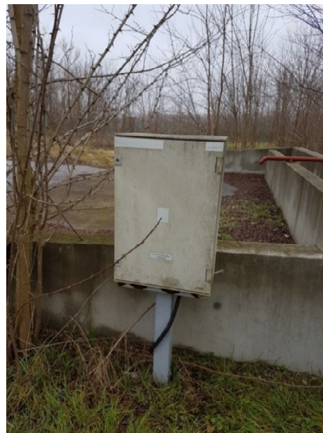
Slika 31. Postojeće stanje platoa za deponiranje
