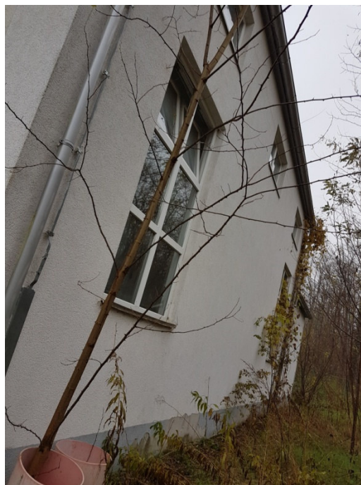
Slika 19. Izgled prozora na postojećoj zgradi CS
