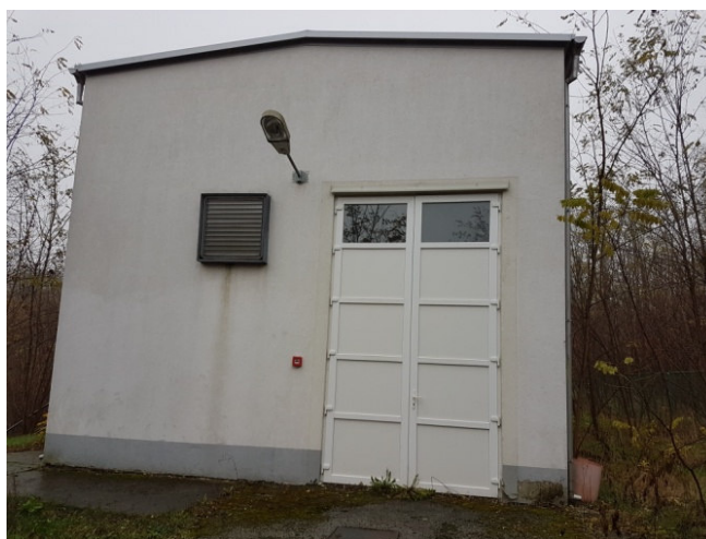
Slika 21. Vanjski izgled postojeće zgrade crpne stanice
