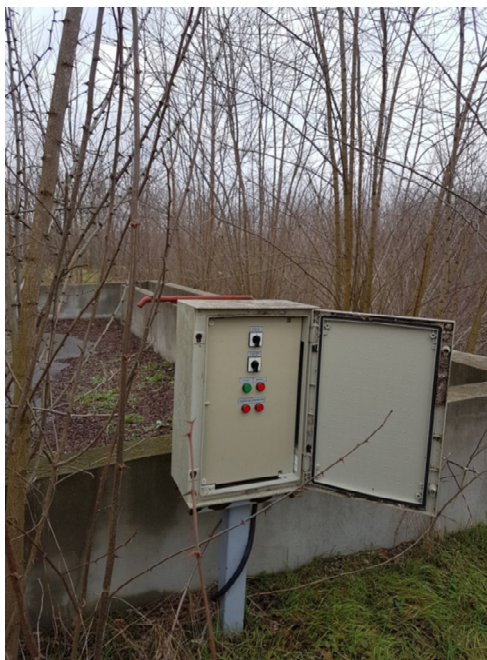
Slika 10. Izgled postojećeg razdjelnog ormara „R“ i ormara i ormara glavne sklopke muljne pumpe
