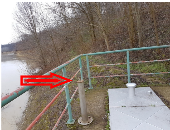
Slika 22. Zasun mehaničke rešetke
