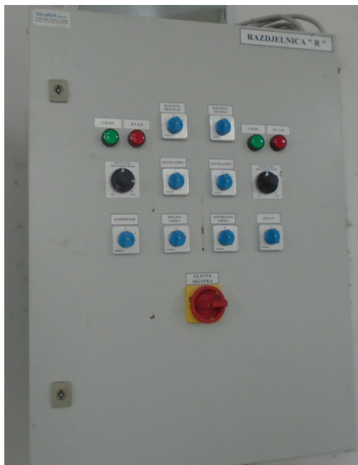
Slika 10. Izgled postojećeg razdjelnog ormara „R“ i ormara i ormara glavne sklopke muljne pumpe
