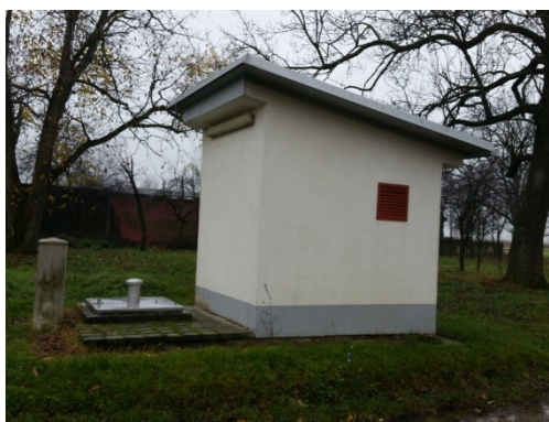
Slika 55. Izgled objekta za smještaj zdenca
