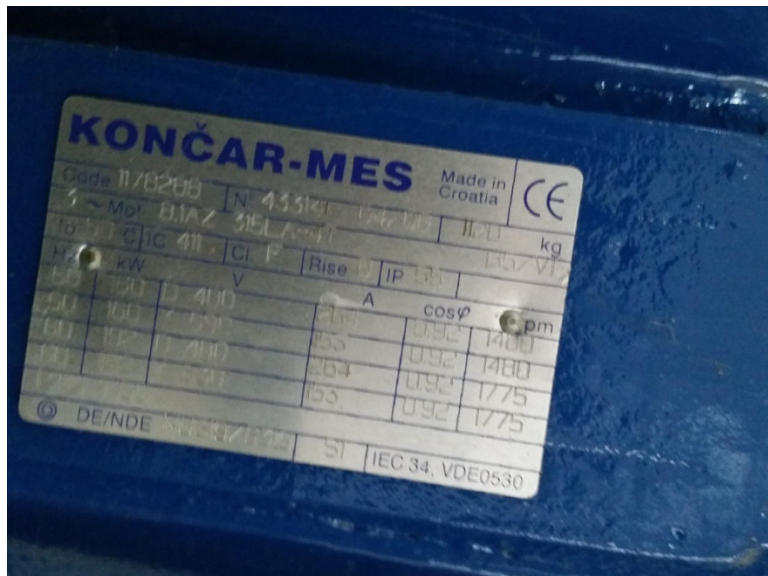
Slika 8. Informacijska pločica postojećeg elektromotora i izgled crpke koja nije u funkciji
