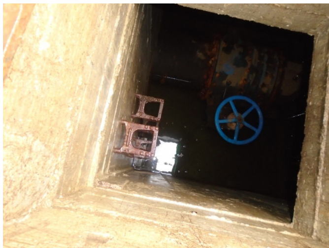
Slika 26. Postojeće stanje Č02
