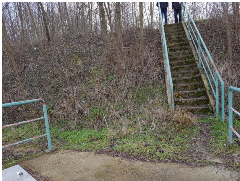
Slika 25. Postojeće stanje stepeništa
