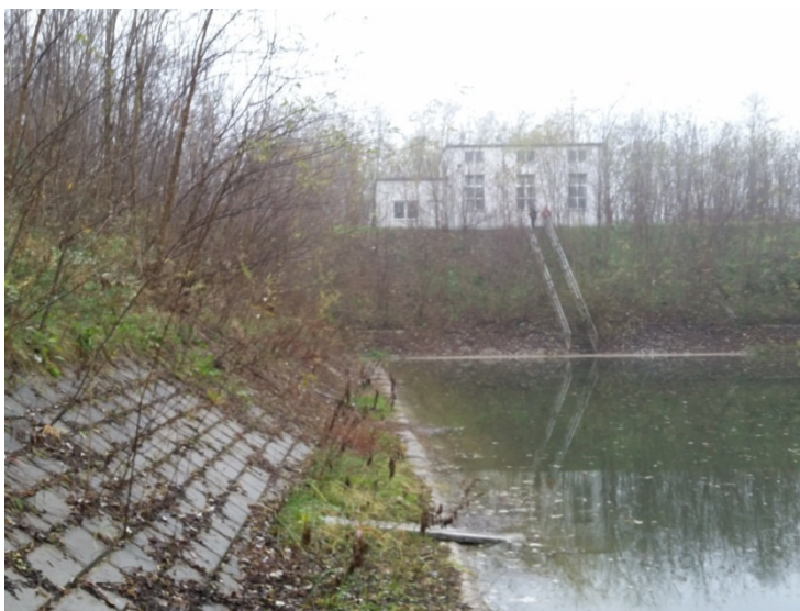
Slika 33. Postojeće stanje stepeništa i pokosa uz taložnicu
