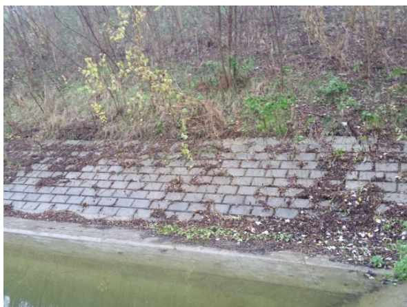
Slika 33. Postojeće stanje stepeništa i pokosa uz taložnicu
