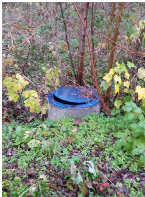
Slika 47. Hidrant za navodnjavanje
