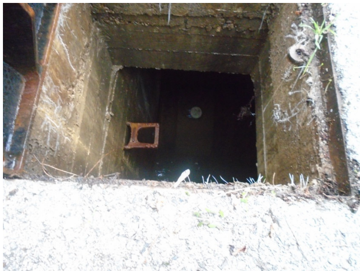
Slika 27. Postojeće stanje Č03
